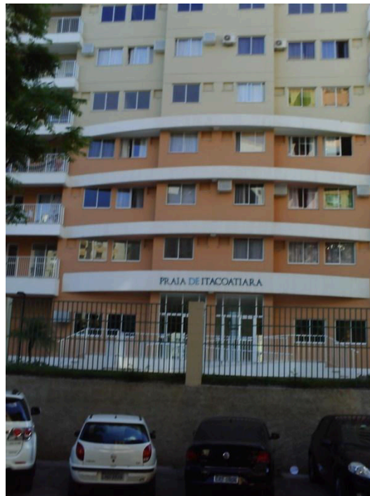
Fotos 5.3f: O empreendimento Parque das Águas, construído pela empresa CR2, na área dos bairros de Mutondo e Alcântara. “Ilha de riqueza” ou “Fantasia”? Fontes: Autor, Outubro de 2012
