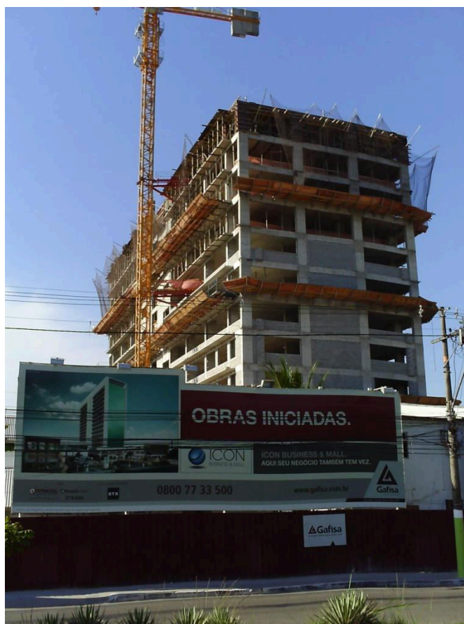
Fotos 5.3c: O Icon Business Mall, empreendimento da empresa Gafisa, localizado no bairro Centro, em São Gonçalo. Fontes: Autor, Outubro de 2012 e www.gafisa.com.br
