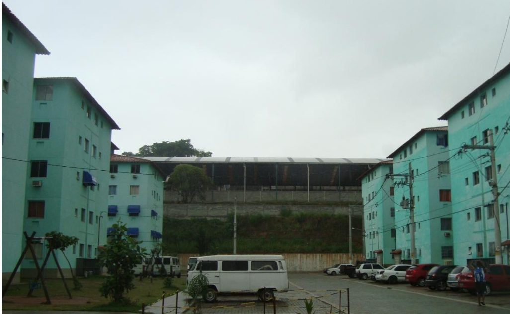
Figura 16. Detalhe para a diferença do nível da construção vizinha ao empreendimento
