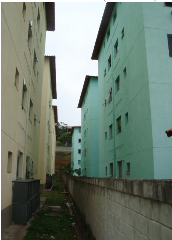
Figura 14. Muro que divide os condomínios San Carlo e San Francesco (Belford Roxo)
