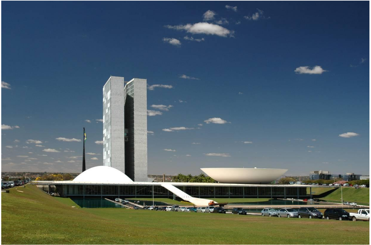
Fig. 7.30. Rampas levando à principal entrada do edifício do Congresso.
