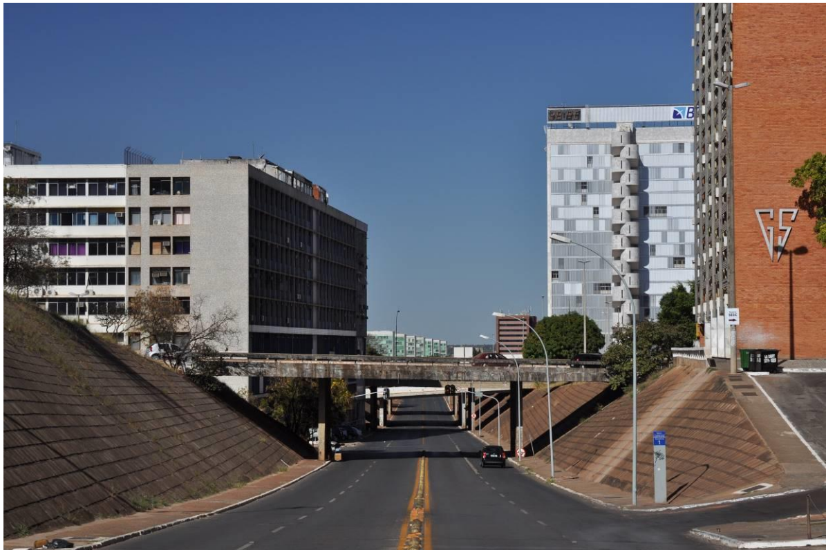
Fig. 7.69. Rua de serviço separando o Setor Comercial Sul do Setor Hoteleiro Sul.
