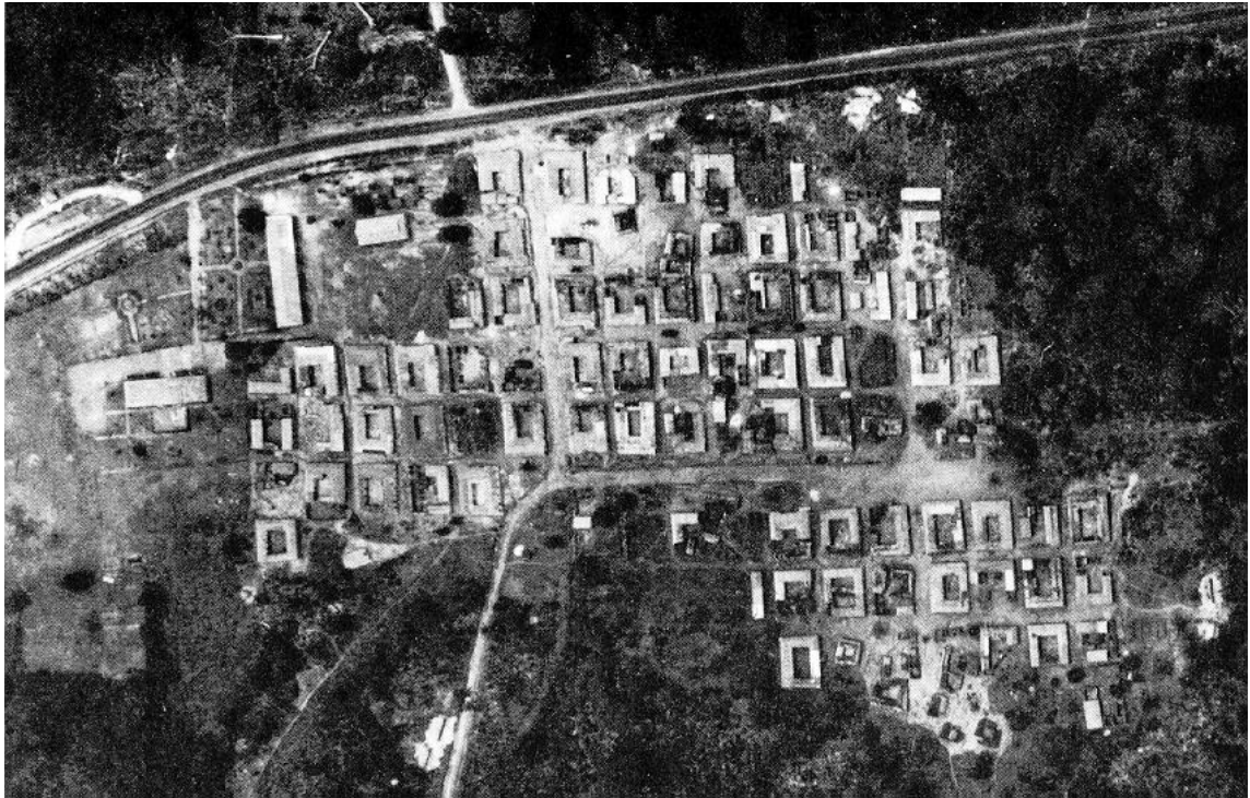
Fig. I.08. Vista aérea da vila ashanti de Fumisua.
