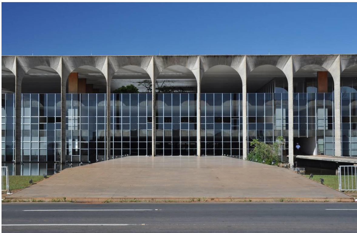
Fig. 7.29. Passarela da entrada do Ministério das Relações Exteriores.
