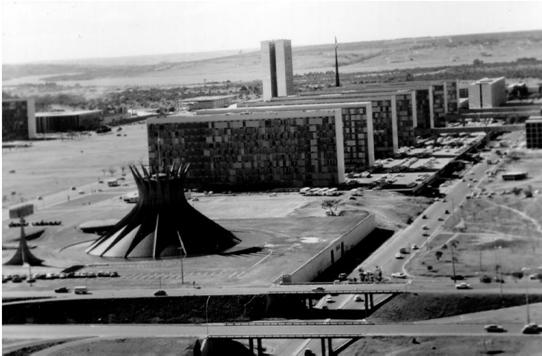
Fig. 7.03. Esplanada dos Ministérios, onde se vê o talude ao longo da via de serviço que passa atrás da Catedral.
