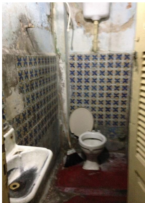
Figura 5 – Banheiro em cortiço da área central do Rio de Janeiro.
