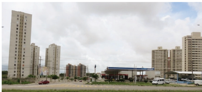
Imagem 7 – Edifícios em frente ao conjunto Cidade Satélite
