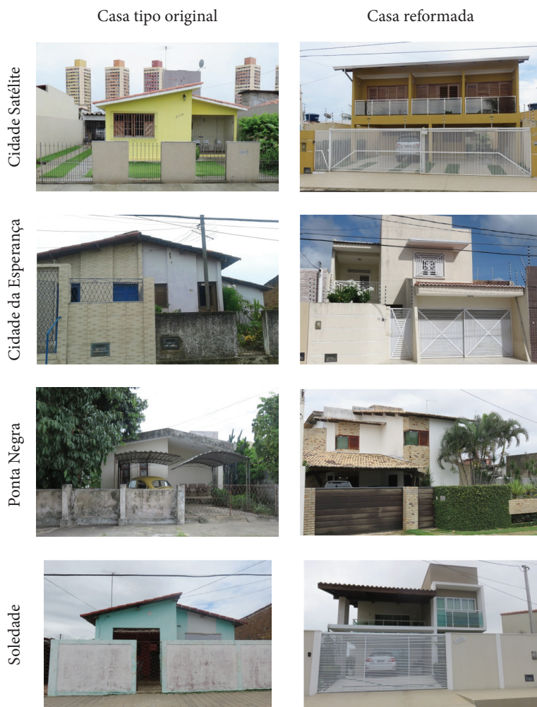
Imagem 12 – Casas nos conjuntos habitacionais pesquisados
