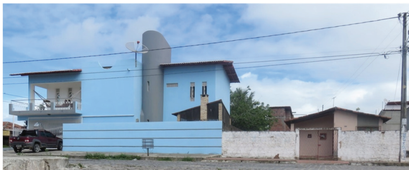
Imagem 13 – Casa reformada e casa padrão, conjunto Soledade
