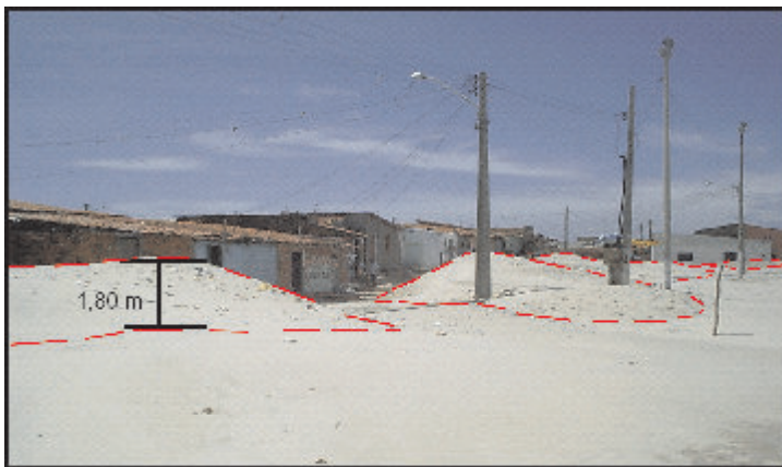
Figura III.23 - Presença de corpos dunares (pontilhados) dispostos sobre a rua Ponta Mar, em dezembro de 2004. Notar que o volume das dunas (altura aproximada de 1,80 m) está obstruindo a entrada das casas.
