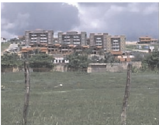
Figura III.8 - Condomínio vertical de veraneio em Porto das Dunas/CE
