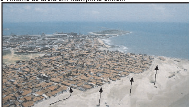
Figura III.21 – Vista panorâmica, evidenciando a presença intensa de residências nas proximidades
