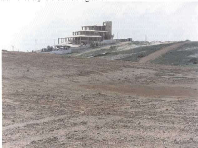
Figura III.17 – Compactação das dunas fixas com saibro para criação artificial de solo.
