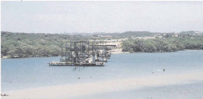
Figura III.14 - Construção da ponte sobre o rio Cocó – 2003. Fonte: Mary Andrade
