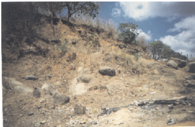
Figura II.25 – Processo de desmoronamento e deslizamento em serras do Maciço de Uruburetama, a oeste do Rio Curu-Ce.F. M. Soares/Janeiro-1999.
