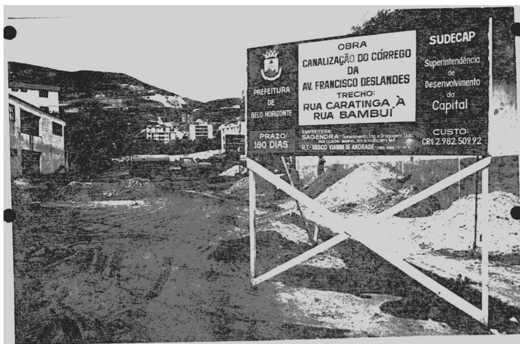
Figura 5 - Canalização do córrego na Francisco Deslandes
