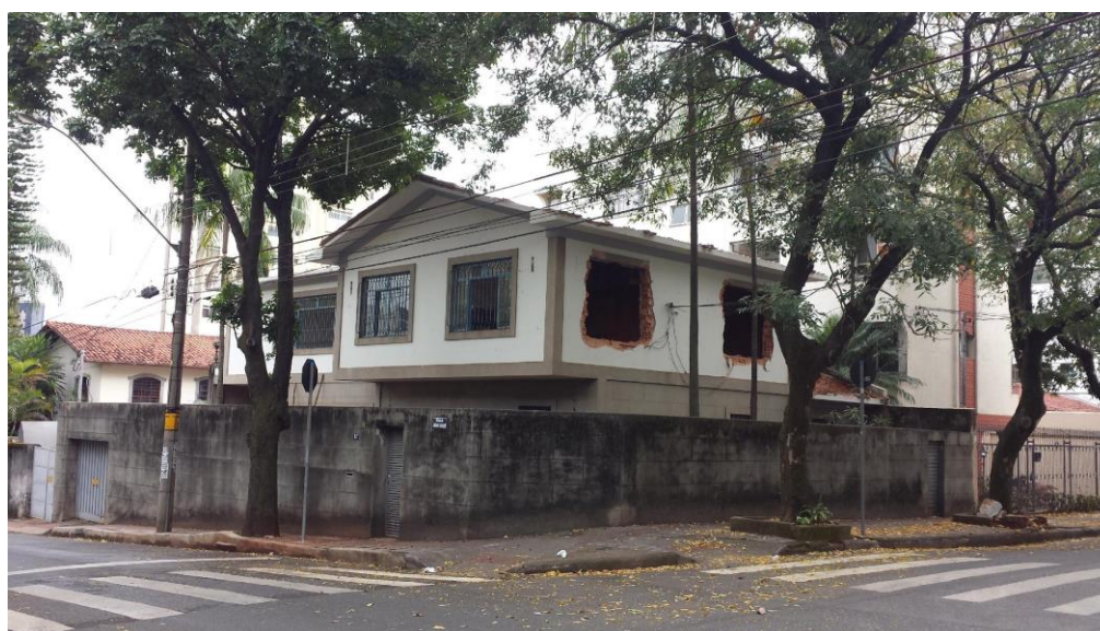
Figura 15 - Casa antiga em processo de demolição (rua Joaquim Linhares)
