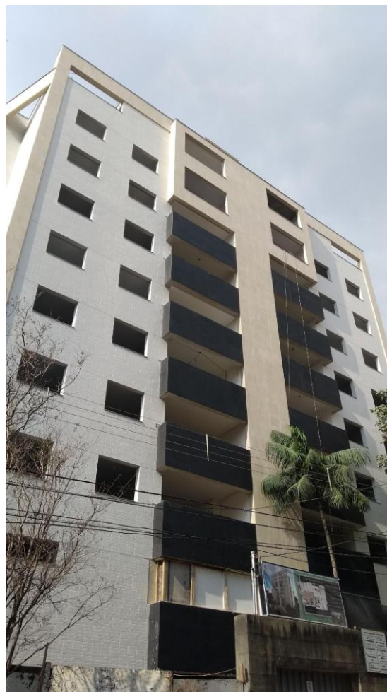
Figura 16 - Residencial Vila Florença em construção (rua Joaquim Linhares)
