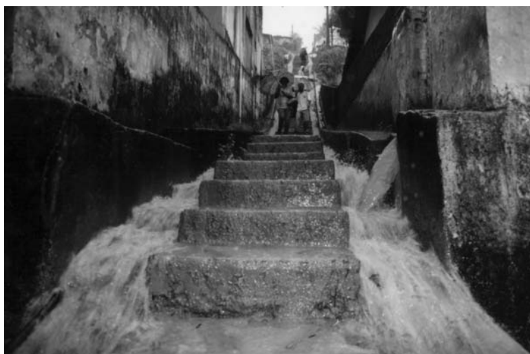
FIGURA 1.9 – Recife: Subdimensionamento de Canaletas em Morro
