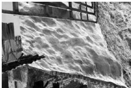
FIGURA 1.14 – Camaragibe: Revestimento da Encosta em Argamassa Sem Tela
