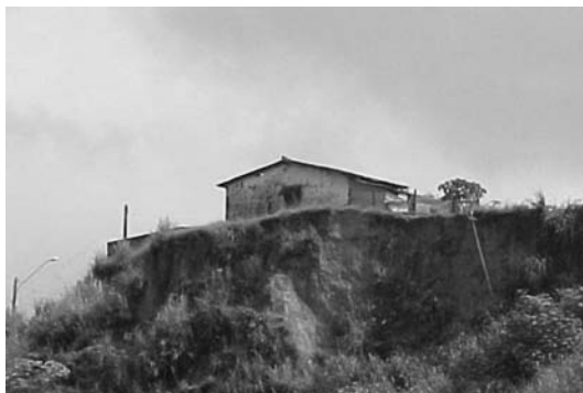
FIGURA 1.10 – Recife: Área de Risco por Erosão em Morro do Ibura
