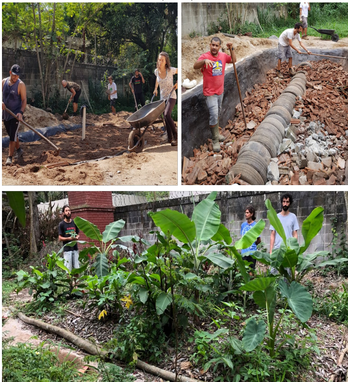
Figura 8: Construção da Bacia de Evapotranspiração (BET)
