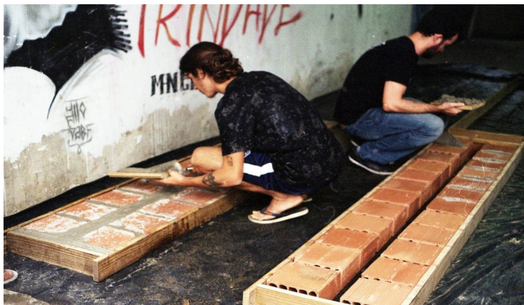
Figura 2: Execução dos painéis de alvenaria armada
