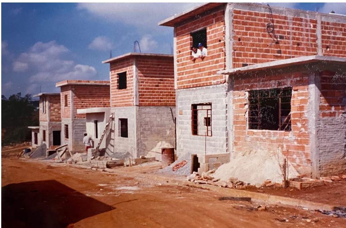
FIGURA 13. Construção em alvenaria
