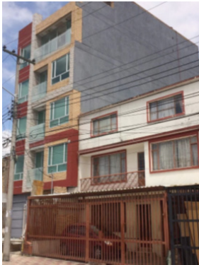
7-5: Inmueble en obra, KA Constructora en Ciudad Jardín. Fotografía tomada en 2018 por M. Charbonnier
