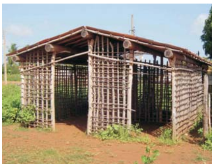
Foto 40 – Casa de taipa em construção na localidade Km 60, Limoeiro do Norte (CE)
