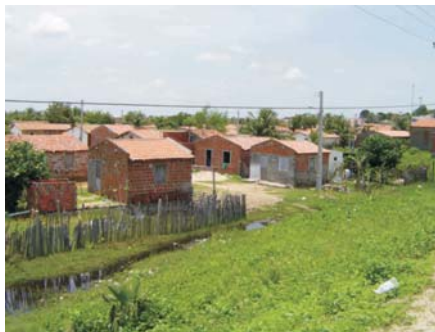
Foto 35 – Ocupação em área de risco em Morada Nova (CE)
