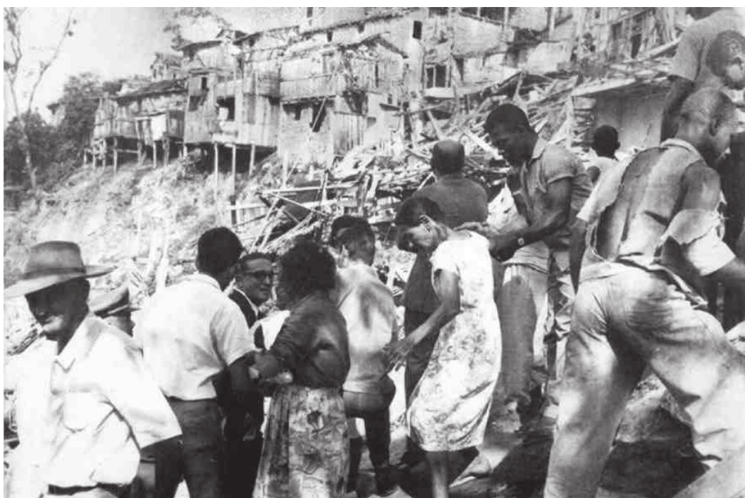
Migrações para os grandes centros urbanos nas décadas de 1950 e 1960 resultam na ampliação dos assentamentos precários. Imagens de incêndio (favela do Esqueleto no Rio de Janeiro -1956) e desabamentos (com a visita do governador do Rio de Janeiro Carlos Lacerda) obrigam o poder público a iniciar as primeiras intervenções.
