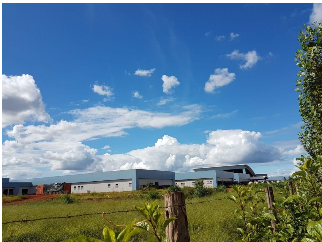
Figura 4: construção do Hospital da Criança de Maringá. Foto: Edna Töws, fevereiro de 2020.
