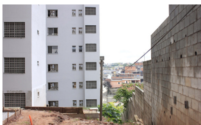
FIGURA 9. Obra construção Fonte: ver nota de rodapé 1.
