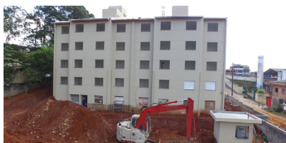
FIGURA 11. Obra construção Fonte: Página Facebook Movimento pela Moradia Leste II, 2019 219 .
