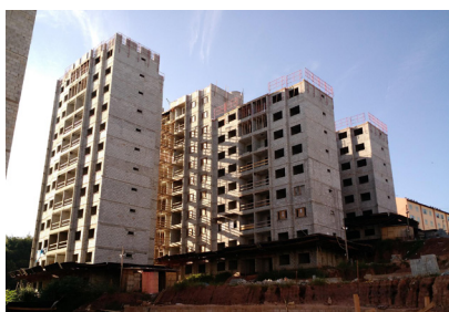
FIGURA 9. Obra construção Fonte: Página facebook Assessoria técnica Ambiente Arquitetura, 2015 30 .
