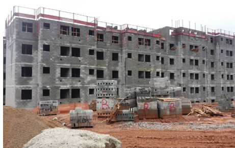
FIGURA 10. Obra construção Fonte: Página facebook GTA - Grupo Técnico de Apoio, 2019 208 .
