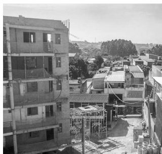
FIGURA 7. Obra construção Fonte: NUNES, A. C., 2017 76 , p. 218
