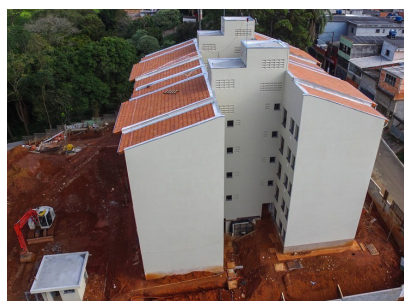
FIGURA 10. Obra construção Fonte: Página Facebook Movimento pela Moradia Leste II, 2019 218 .
