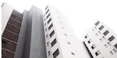
FIGURA 9. Obra construção Fonte: RODRIGUES, E. L.; TERRA, M. de J.; MIRON, R.; VALERIO, W. de S., 2019. p. 59
