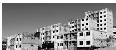
FIGURA 10. Obra construção Fonte: ver nota de rodapé 1.
