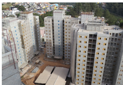
FIGURA 9. Obra construção Fonte: Página facebook Assessoria técnica Ambiente Arquitetura, 2019 39 .
