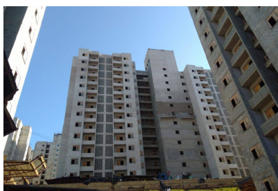
FIGURA 9. Obra construção Fonte: Página facebook Ambiente Arqui. 2020 21 .
