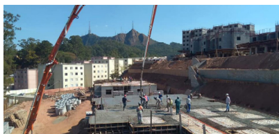
FIGURA 11. Obra construção Fonte: Página facebook Ambiente Arqui, 2019 23 .
