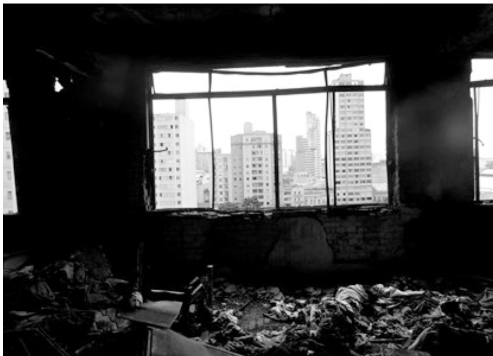
FIGURA 20. 7º Andar do Bloco A após incêndio em 2018
