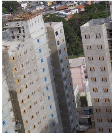
FIGURA 3. Obra construção Fonte: Página facebook Assessoria técnica Ambiente Arquitetura, 2019 35 .
