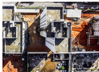
FIGURA 10. Obra construção Fonte: Página facebook Movimento pela Moradia Leste II, 2016 199 .
