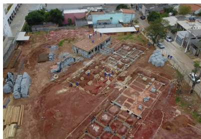
FIGURA 11. Obra construção Fonte: Página Facebook Movimento pela Moradia Leste II, 2020 213 .
