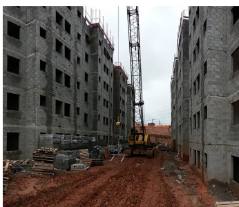
FIGURA 9. Obra construção Fonte: Página facebook GTA - Grupo Técnico de Apoio, 2019 207 .
