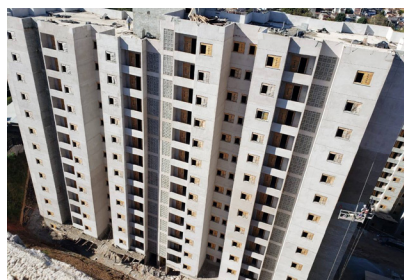
FIGURA 10. Obra construção Fonte: Página facebook Assessoria técnica Ambiente Arquitetura, 2020 40 .
