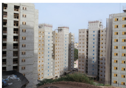
FIGURA 10. Obra construção Fonte: Página facebook Assessoria técnica Ambiente Arquitetura, 2019 31 .
