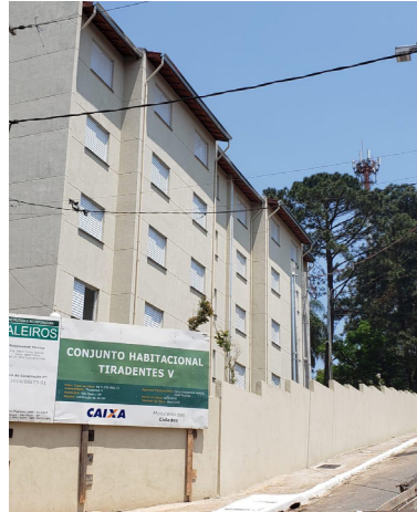
FIGURA 3. Obra construção Fonte: Página Facebook Movimento pela Moradia Leste II, 2019 215 .
