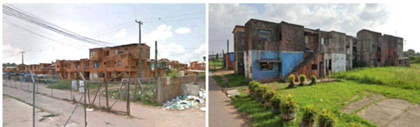
Figura 4 e 5 - Blocos residenciais não finalizados e ocupados no Residencial Liberdade I e II, bairro da Terra Firme, em Belém; e blocos residenciais não finalizados e ocupados no Residencial Ive Portela, no bairro do Paracuri em Icoaraci.
