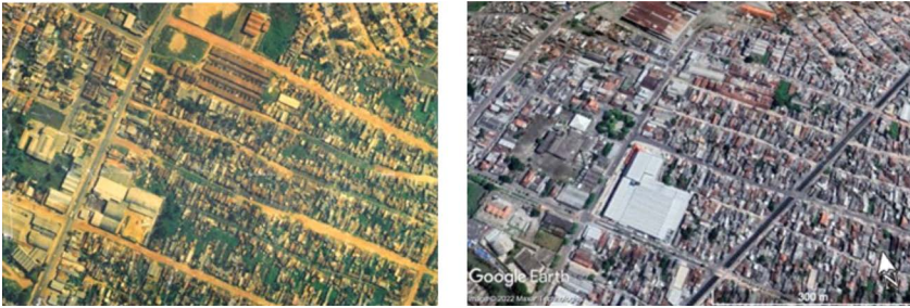
Figura 2 - Imagem de uma porção do bairro da Sacramento, localizado na Bacia do Uma; à esquerda, aerofoto de 1986 (CODEM, 1986), observe a constituição das pontes de acesso às edificações (localmente denominadas estivas); à direita imagem capturada do Google Earth, com destaque para o canal de macrodrenagem, a substituição do casario e o asfaltamento, bem como a mudança de padrão de edificações não residenciais ao longo da avenida Sen. Lemos (objeto de projetos de melhorias em ciclos).
