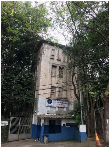
Figura 21: Torre da Elni.
