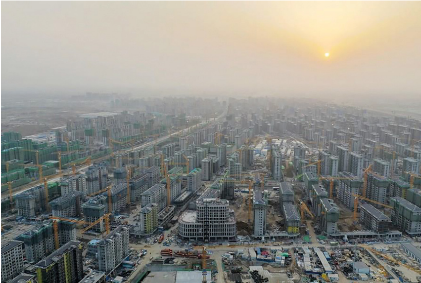
Figure 40 – Vista dos projetos de construção em Xiong'an
