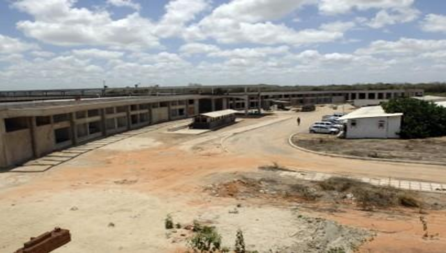
Campus do Cérebro, em Macaíba, projeto de 32 mil m 2 , em execução (paralisado). Foto: Novo Jornal.
